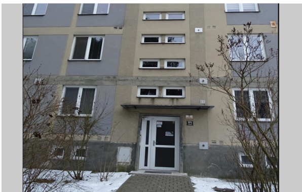
Pohled na vstup do budovy
