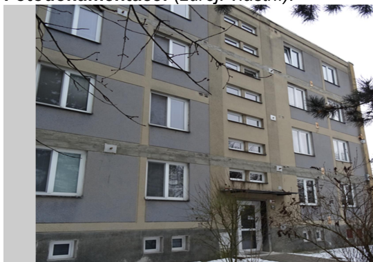
Pohled celkový na bytový dům Nejedlého ev.č.374
